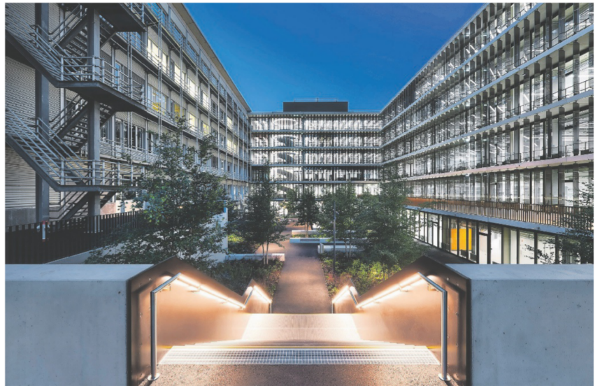
So sieht das neue Laborgebäude UZI 5 auf dem Campus Irchel aus.
